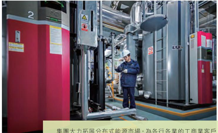
集團大力拓展分布式能源市場，為各行各業的工商業客戶提供更高效率的能源服務，當中包括圖中的國際化妝品品牌之生產基地，將天然氣鍋爐產生之水蒸氣為生產線供暖、進行容器消毒和置換熱水等工序。
