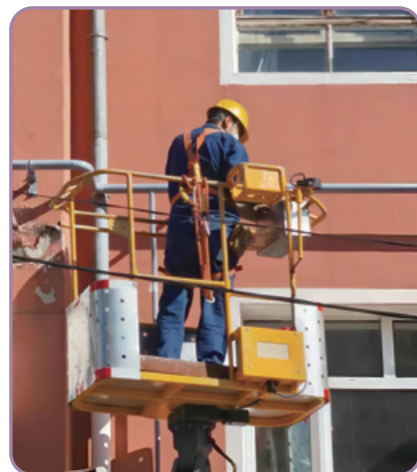
④ 燃气管线现场勘察
