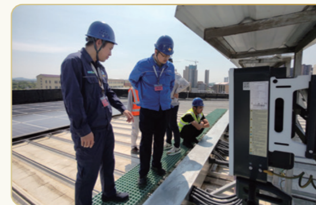
集团工程部安全管理组对已建或投产的项目进行工程—运维—安全联合巡查 (可再生能源业务)
