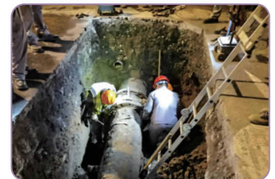
④ 燃气管线改造施工现场
