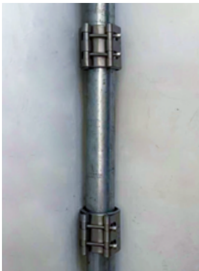
應用改進型不鏽鋼柔性搶修節維修的立管
