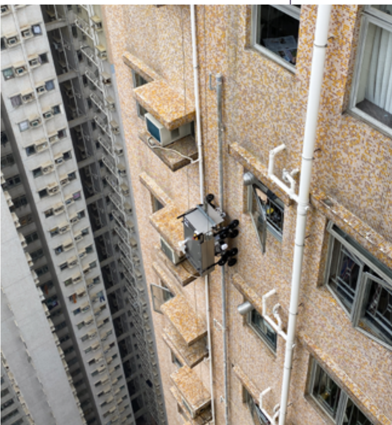
員工通過智能機械人進行立管維修，避免高空作業風險
