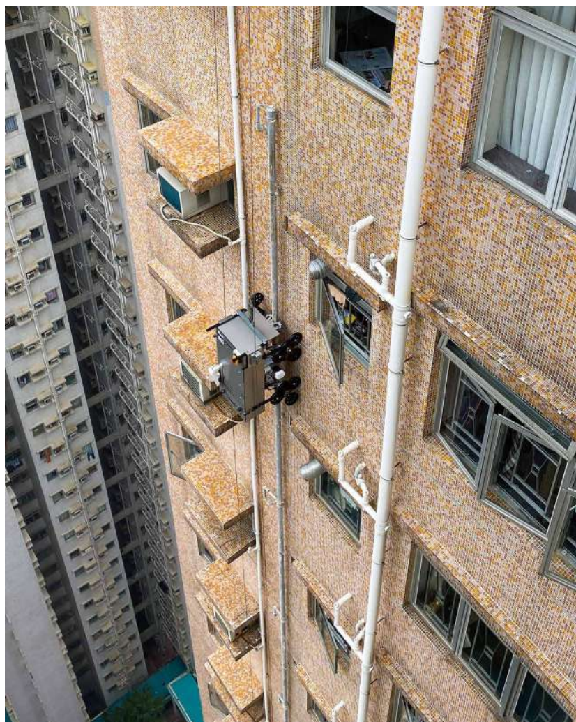
通過智能機械人進行立管維修，延長立管使用壽命
