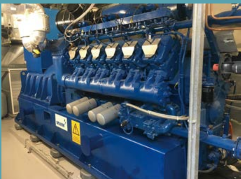
熱電聯供系統以沼氣發電, 提供電力及熱能予醫院部分設施, 轉廢為能
