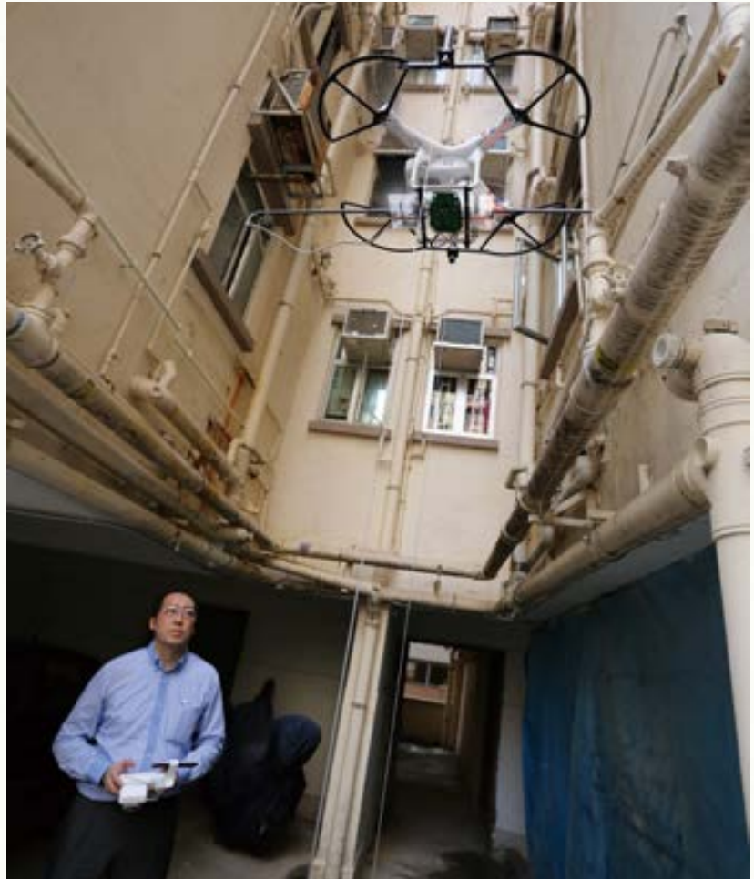
這架總重量1.35千克的飛行器從地面沿固定索道騰空而起,把數十層大樓的煤氣立管好好檢查一遍
