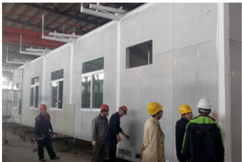
模塊站房工廠預組裝現場圖
