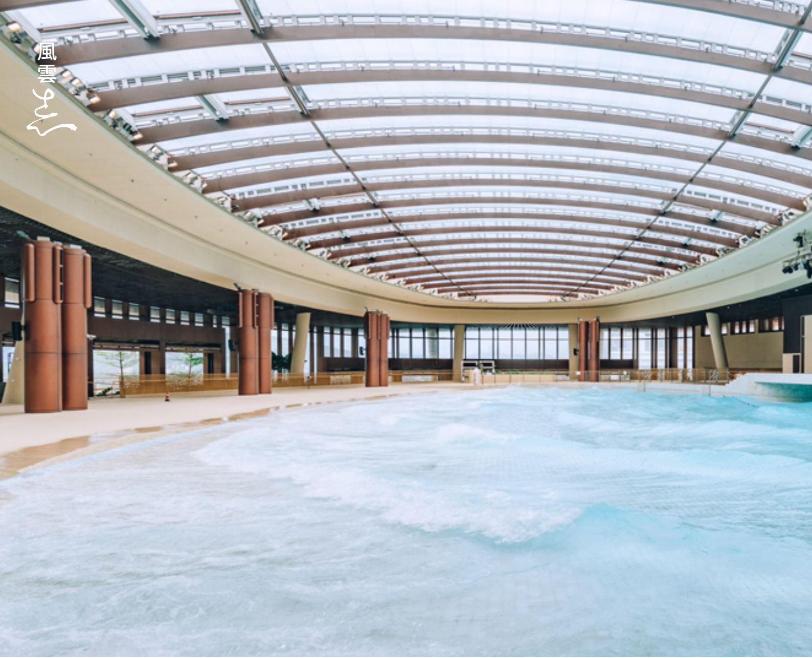
香港中華煤氣為亞洲首個全年全天候臨海水上樂園提供環保設備
