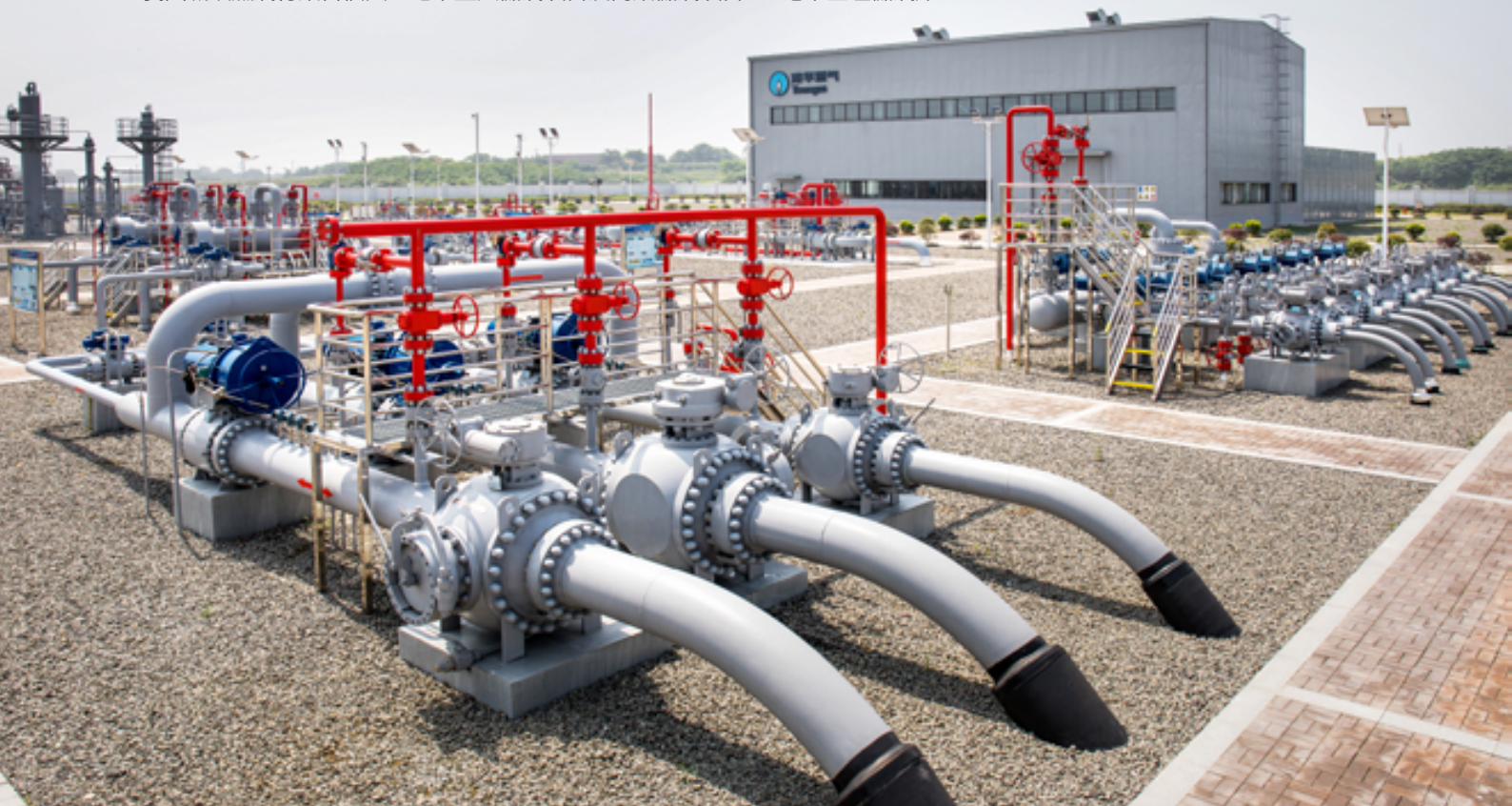
我國城鎮燃氣行業首個大型地下鹽穴儲氣項目及商業儲氣項目——港華金壇儲氣庫
