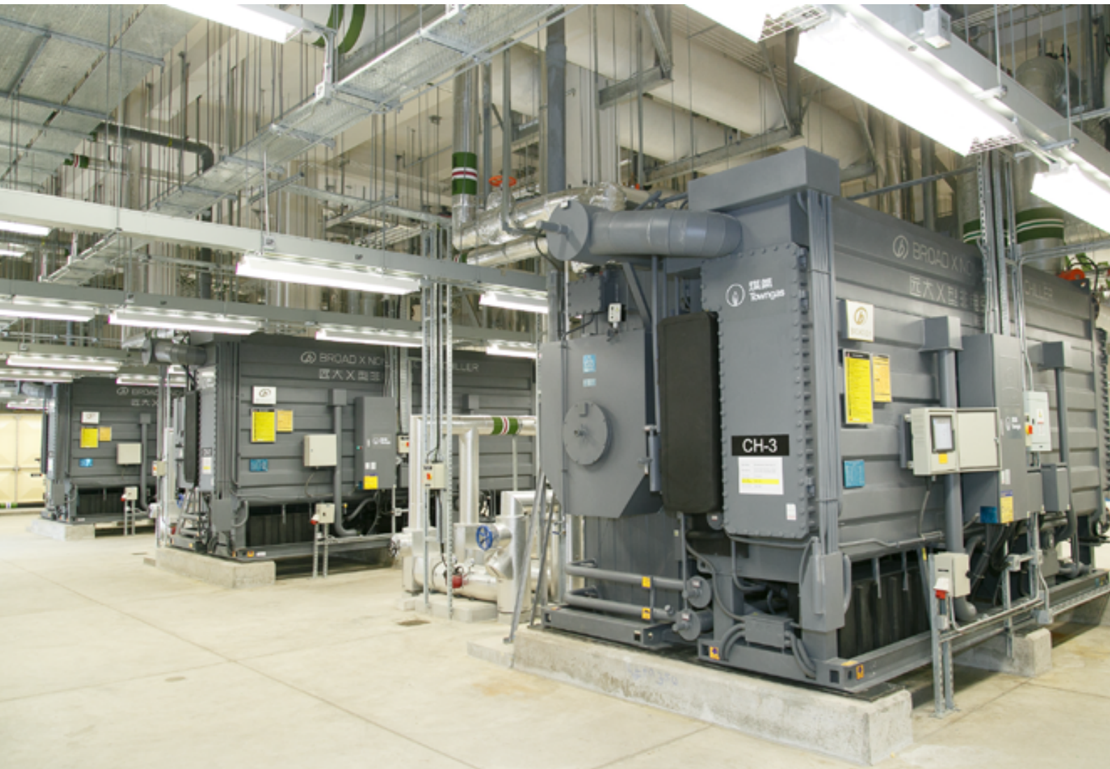
名氣通數據中心採用直燃型吸收式冷熱水機組，減少碳排放
