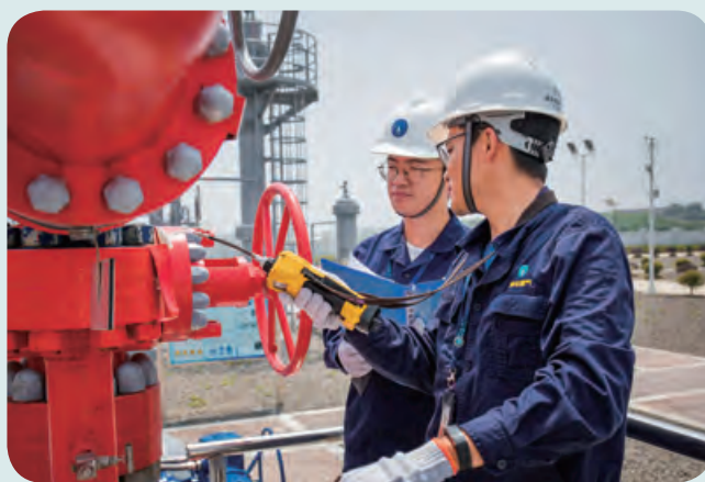
「港華金壇儲氣庫」善用鹽穴儲存量大、安全性高的特點，於燃氣使用量低時將餘氣量儲存起來，在用量高峰時段抽出來補充供氣量，做到調節供應的效果。
