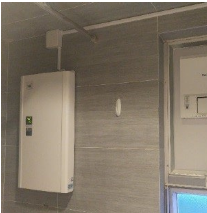
公司技術人員發揮「能工巧匠」精神，利用電線槽把超薄熱水器的外露電線整齊連接
