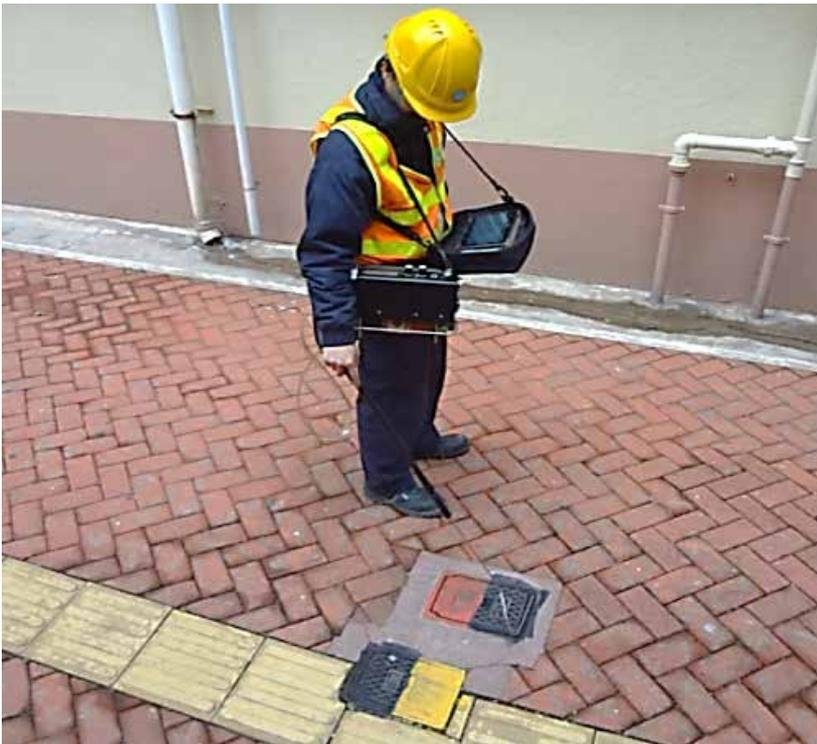
現在，工作人員借助管網洩漏檢測(巡線)系統進行巡線
