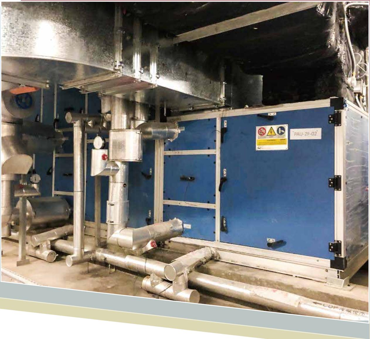
房空間不足的難題，公司創新性地將鮮風櫃、煤氣抽濕機及熱交換器三合為一，透過把抽濕輪放入鮮風櫃，利用煤氣熱水爐所產生的熱水經熱交換器加熱空氣，再藉助熱空氣烘乾除濕輪，還原其除濕能力的方式，取代傳統直燃式抽濕機
