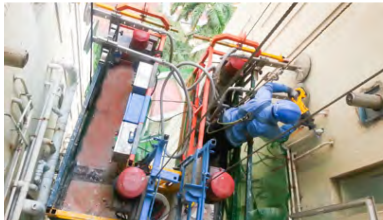
用「聰明船」更換及維修立管
