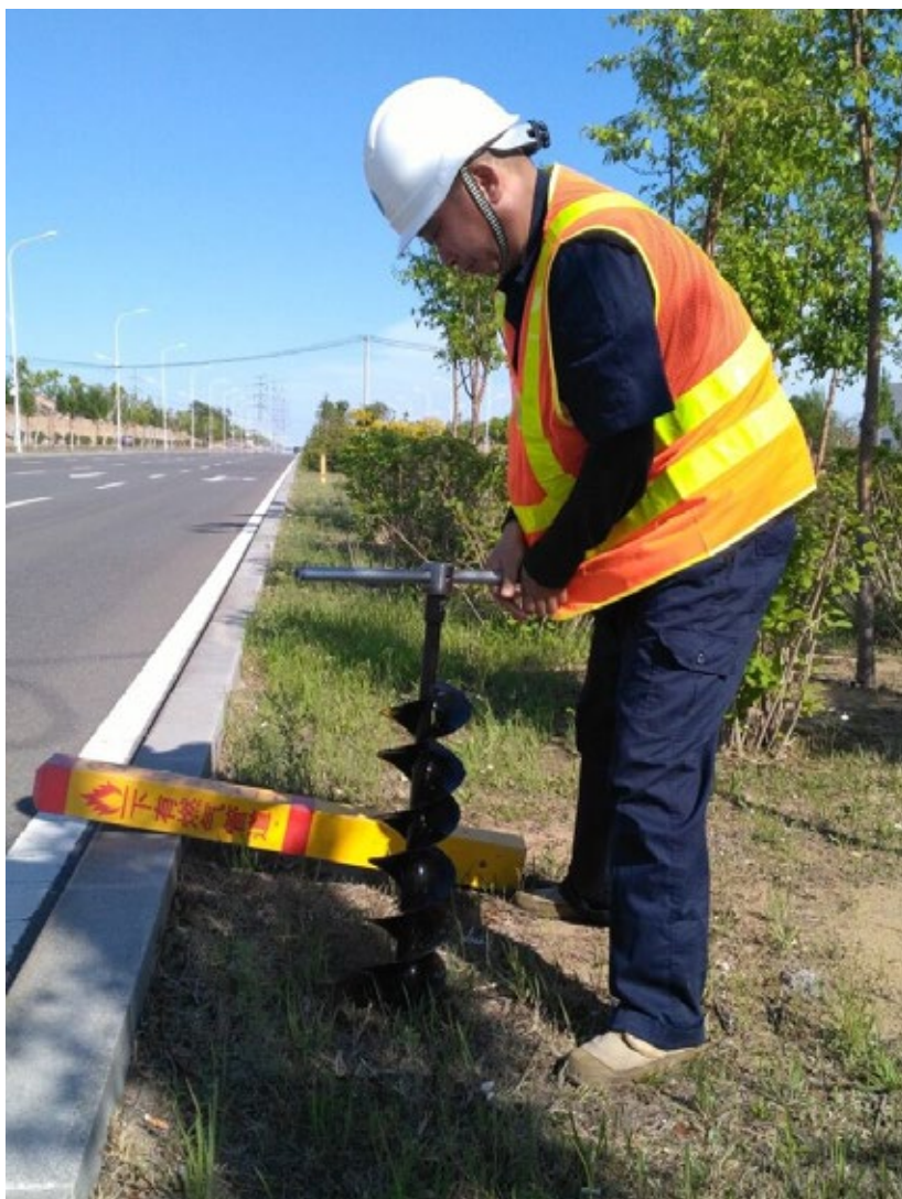
巡線人員使用管線標誌樁埋設器開挖運作坑
