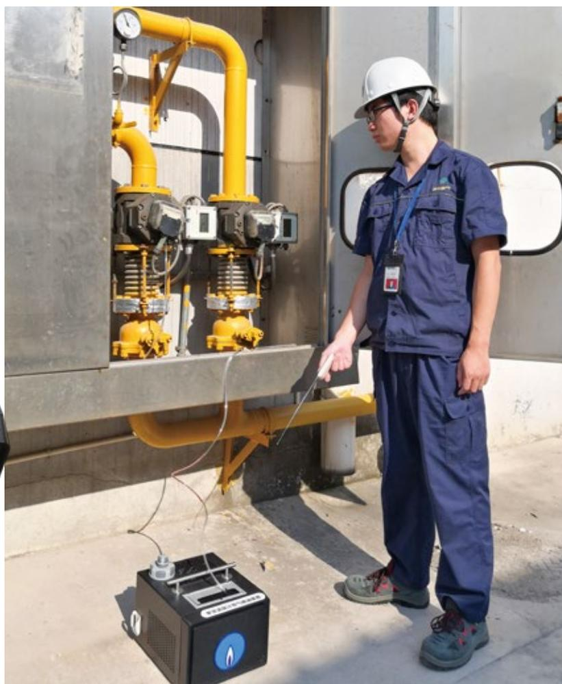
工作人員使用羅茨流量計帶氣換油裝置進行換油
