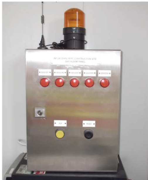
信號傳送至煤氣監控中心及地盤警報器
