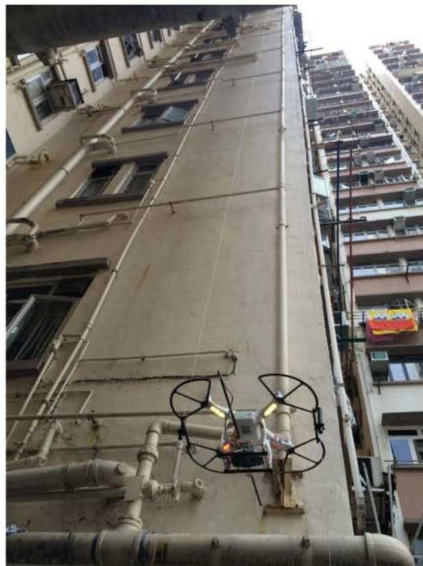
集團發明的立管檢測飛行器作業中
