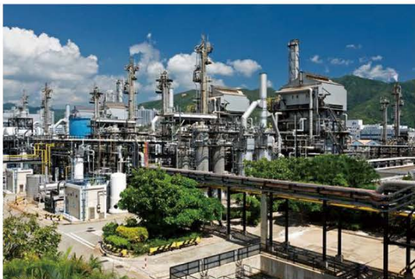
2006年卓誠承建香港大埔煤氣廠改裝工程
