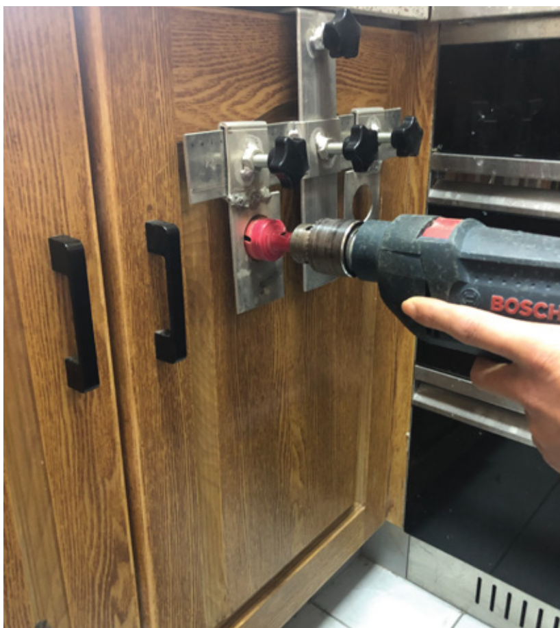
工作人員使用廚櫃門開孔定位器開孔
