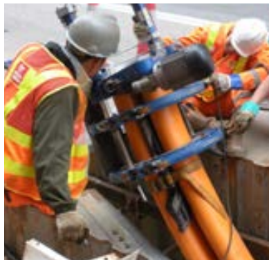
使用自動對熔方法將U形管之管末封好
