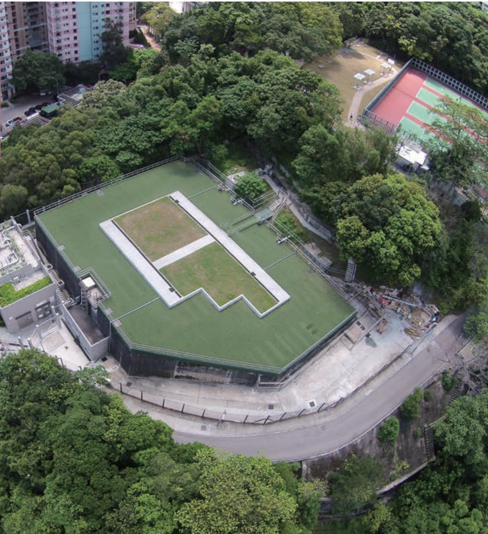
卓裕為香港政府水務署建造的實雲徑海水抽水站及配水庫上蓋加建工程
