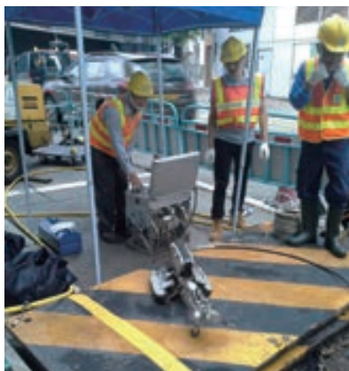
多功能機械人Laparobot在管道內將Syphon Pipe切走
