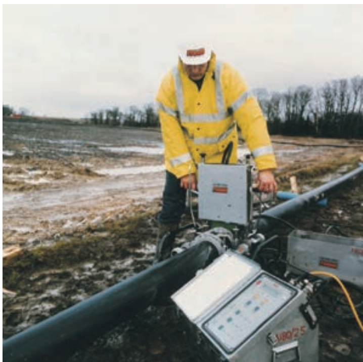
第一代英國Fusion全自動熱熔對接焊機
