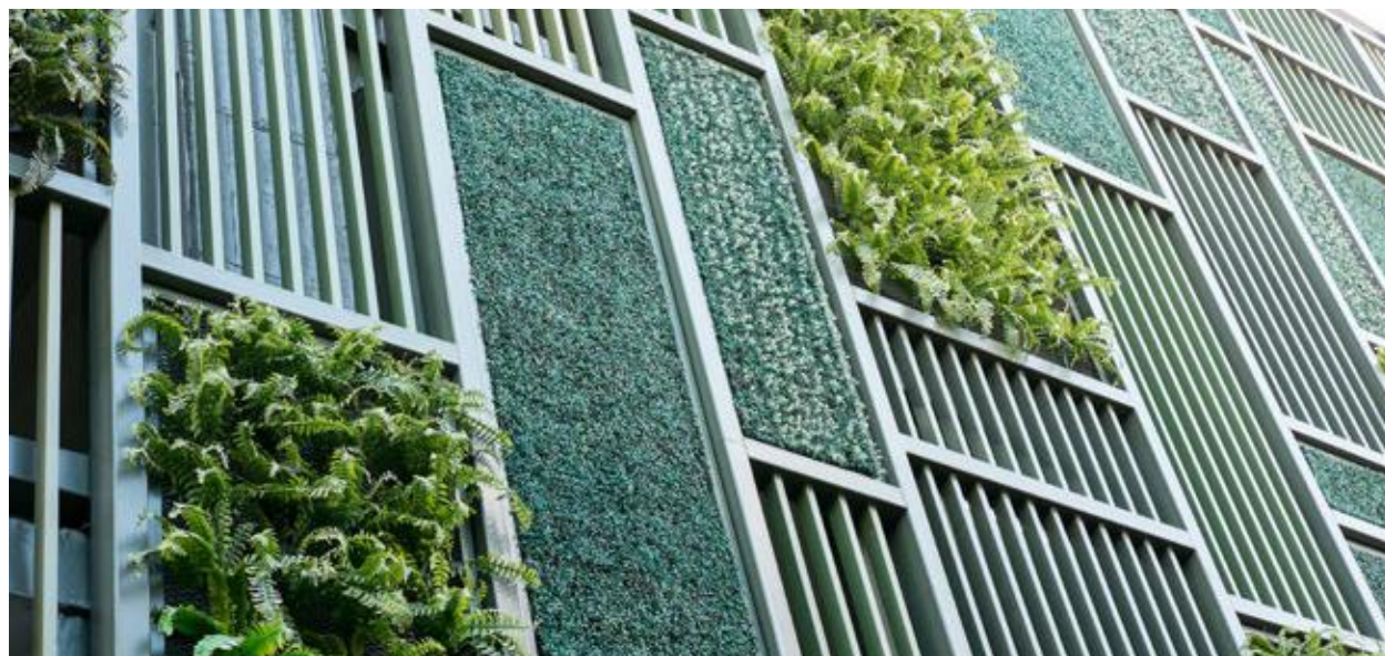
建築物外牆的植物可以遮擋太陽輻射，並通過蒸騰作用吸收熱量，降低室內溫度
