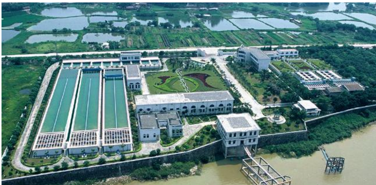
佛山水務環保股份公司旗下位於佛山市高明區的自來水廠全景圖
