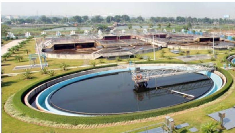
佛山水務項目位於南海區西樵鎮的污水處理廠沉澱池
