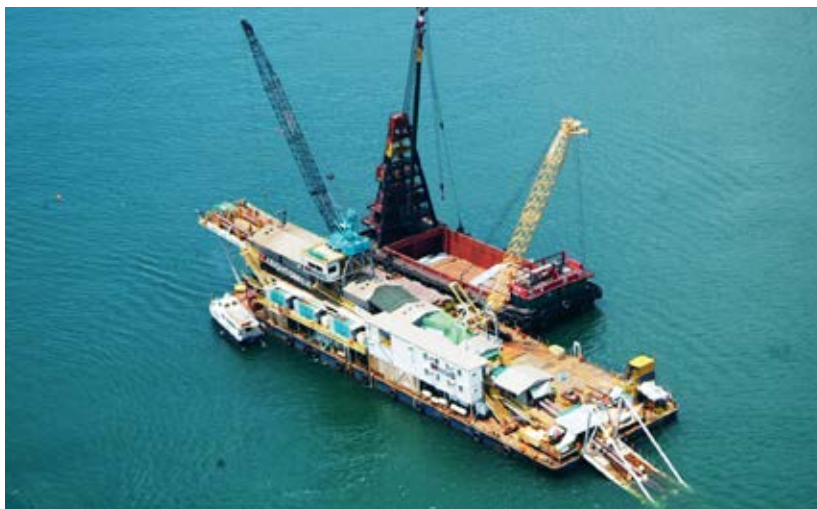
天然氣高壓海底管道正在鋪管運作
