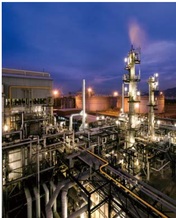
大埔煤氣廠的石腦油儲罐
