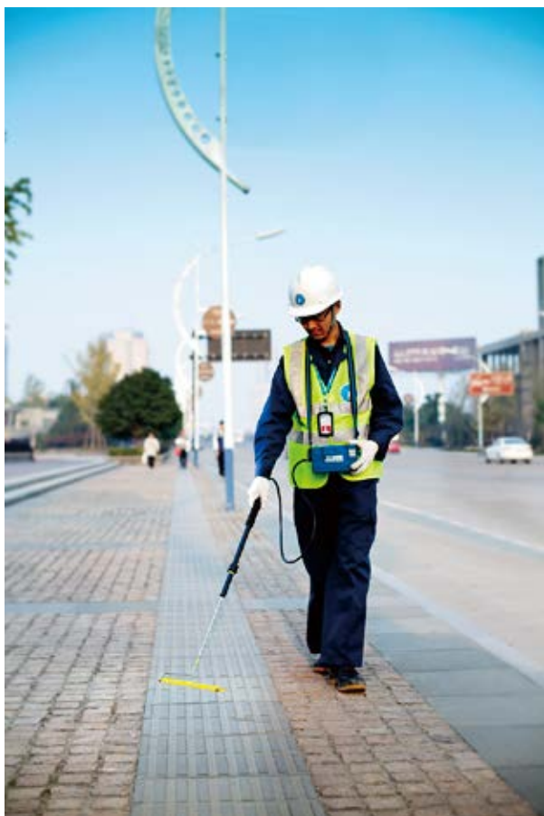
每日開展管網巡線工作，保障供氣安全
