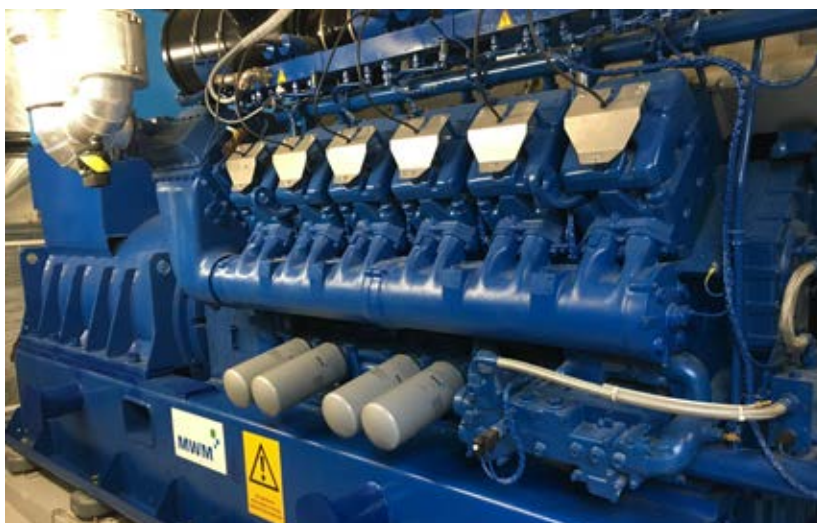
熱電聯供系統以沼氣發電，提供電力及熱能予醫院使用，轉廢為能
